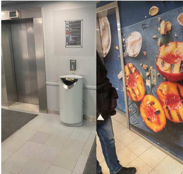
Koira koulutetaan ohjaamaan hissipainikkeen kohdalle. Painikkeiden tulisi erottua selvästi taustastaan eikä niiden edessä tulisi olla esteitä.
