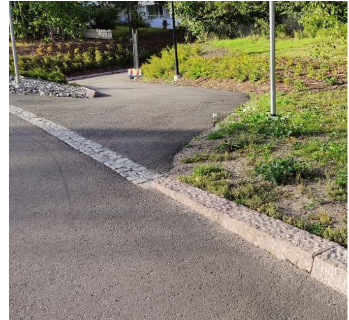
Väylän reunan jatkuvuuden osoittaminen noppakiviraidalla. Jatkuvuuden varmistamiseksi on tärkeää osoittaa väylien risteyskohdat ja ohjata niiden yli. Toinen vaihtoehto on merkitä koko risteysalue eri materiaalilla.
